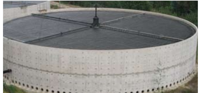
Fig. 27: Tanques de almacenamiento superficiales y semienterrados 32
