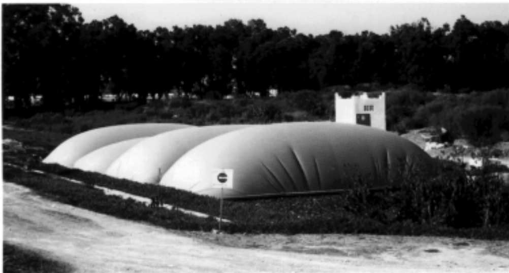
Abb. 7.2: Die vier auf dem anaeroben Absetzteich schwimmenden Gasometer
