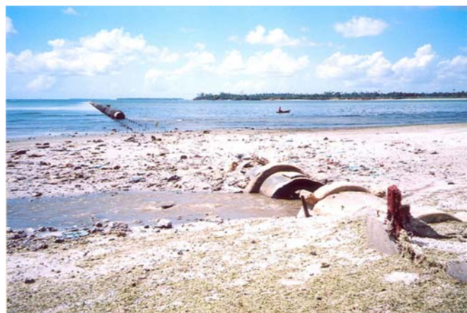
Abbildung 26: Sea outfall Dar es Salaam Quelle: Eigene Aufnahme
