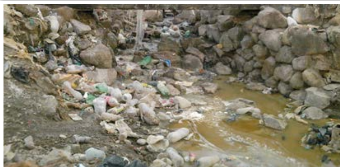
Canal de agua residual y minera
