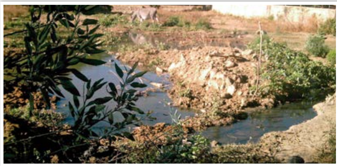
Vista vertido de efluente en terrenos aledaños a la PTAR aún en construcción
