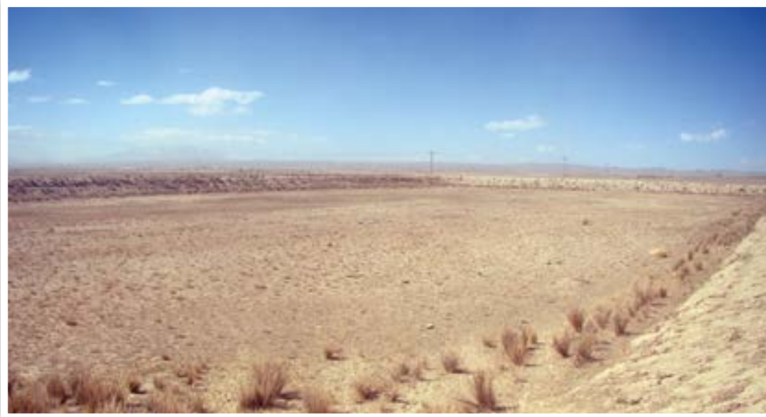
PTAR que nunca fue utilizada
