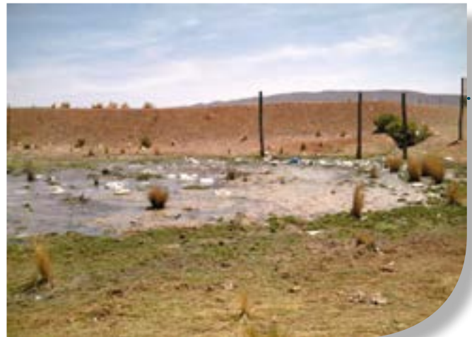
Foto 20. Lagunas de estabilización sin mantenimiento. Eucaliptus, Oruro
