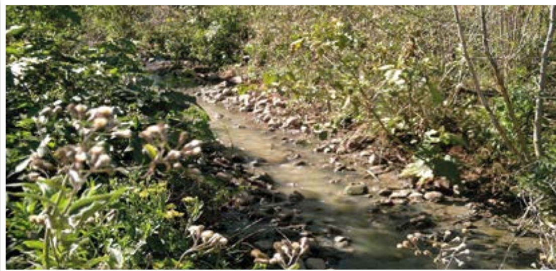
Canal de Riego
