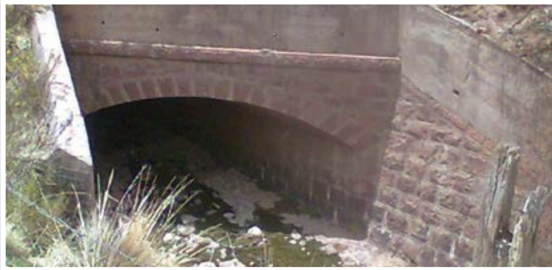
Agua residual vertida directamente al río
