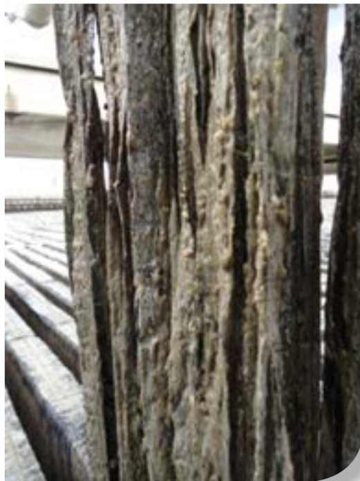
Foto 14: Biopelícula de los filtros percoladores en la ciudad de El Alto, La Paz
