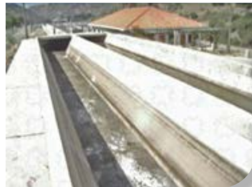
Foto 4: Desarenador en PTAR de Sucre
