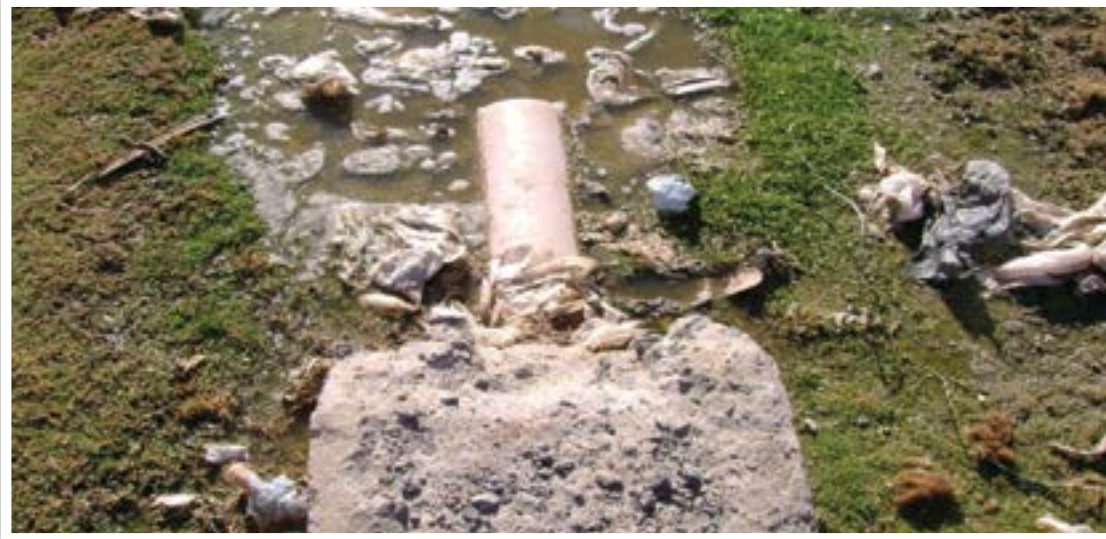
Afluente vertido en terrenos aledaños a PTAR
