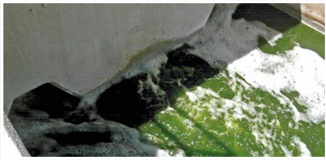
Vista de salida efluente de la PTAR
