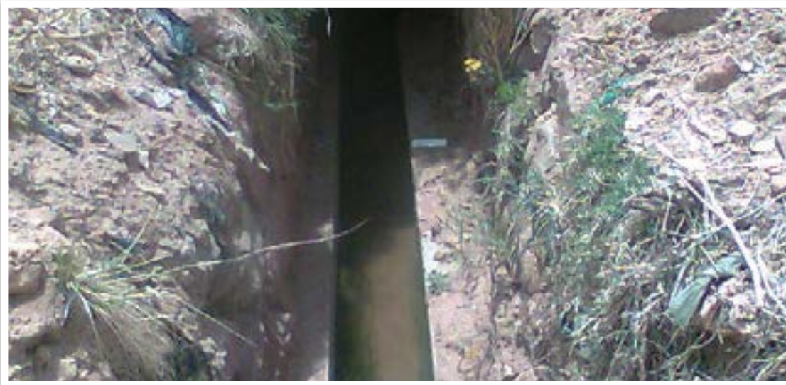
Canal de Riego
