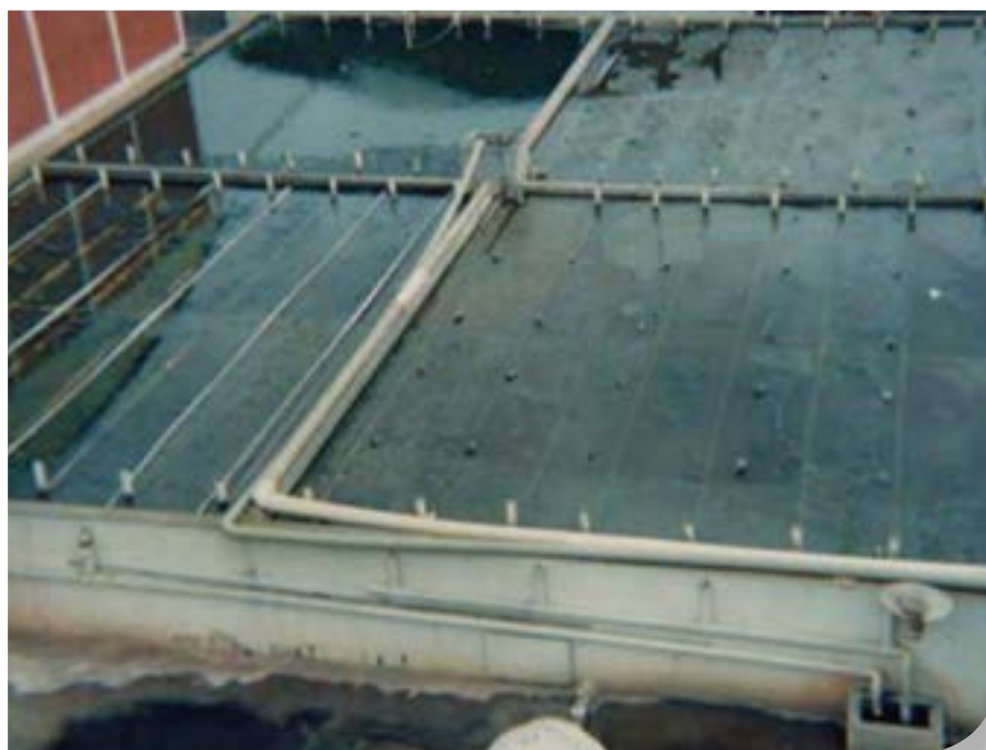
Foto 7: Filtro anaerobio
