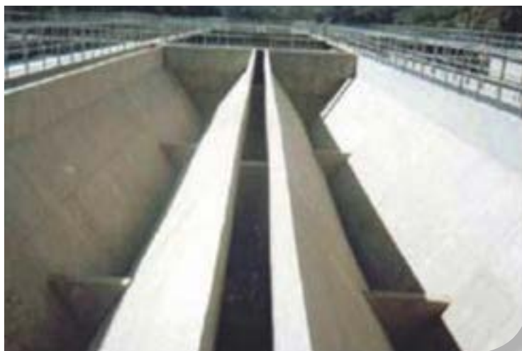
Foto 5: Tanque Imhoff en Sucre, Chuquisaca
