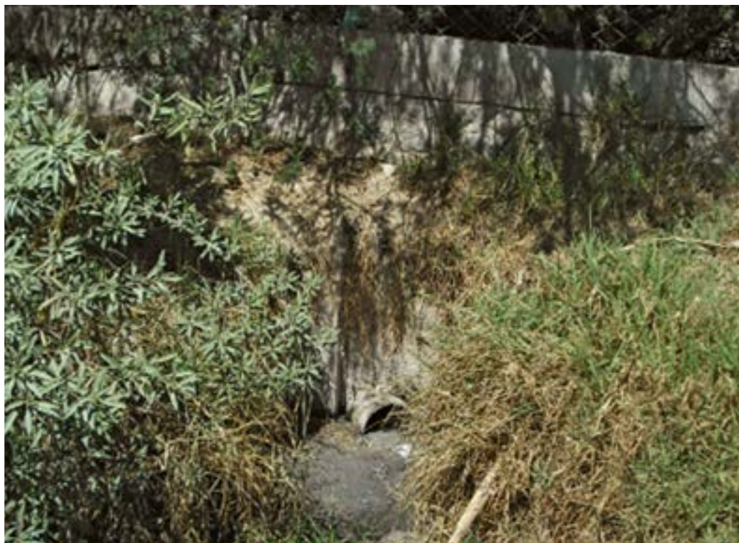
Afluente de la PTAR
