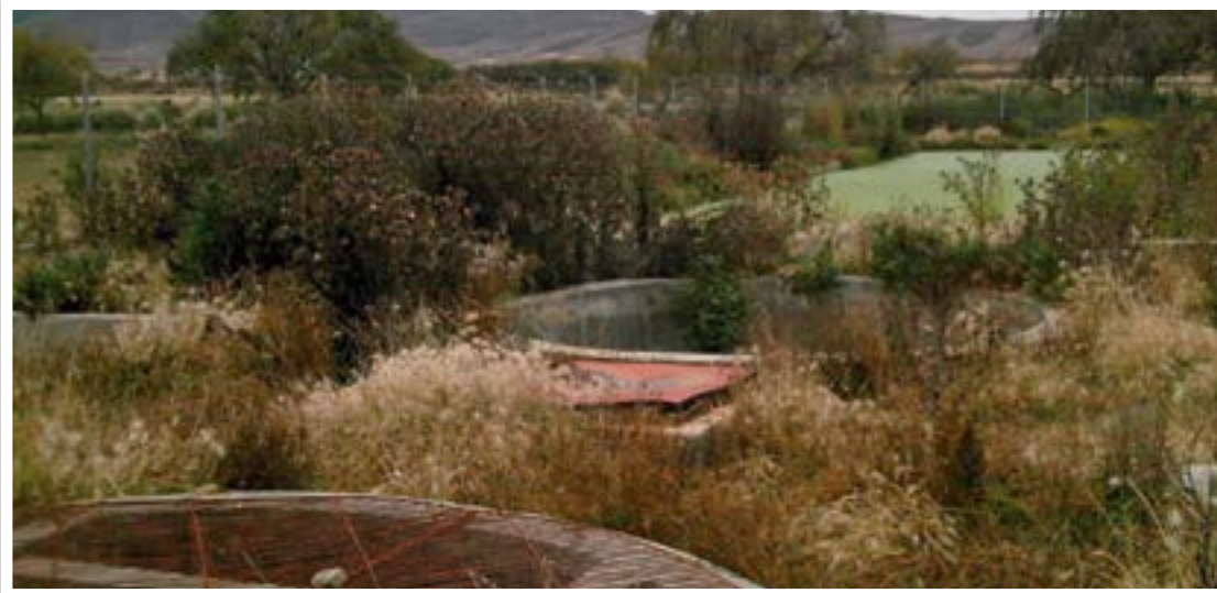
Vista PTAR Imhoff y lagunas
