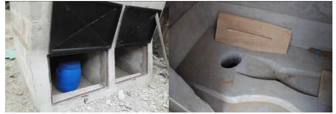
Fig. 7: Latrines EcoSan domestiques (source: E. Albert, 2014)
