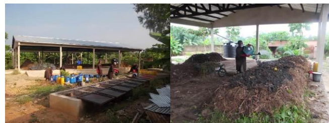
Fig. 5: Traitement d'hygiénisation des excréta (gauche) et fabrication d'andains de compost (droite) (source: A. Dubois, 2014)
