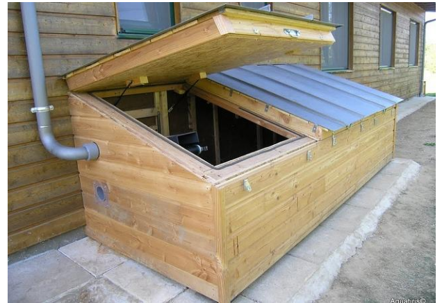
Figure 3: Chambre de compostage associée à la toilette à compost pour un ménage en France (source: E. Le Douarin, 2010).
