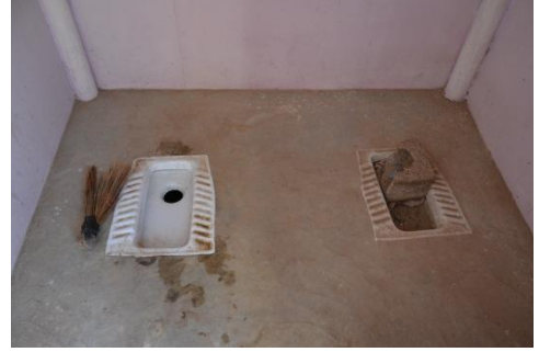
شكل رقم 9: تستخدم البالوعتان بالتناوب ويبقى الحوض الأيسر مغلقا إلى حين امتلاء البالوعة اليمنى
