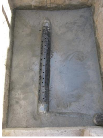
شكل رقم 8: أنبوب الصرف المتصل للآبار التصفية
