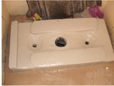
شكل رقم 11: حوض ذو ثلاث فتحات للفصل مصنوع محليا (نواكشوط)
