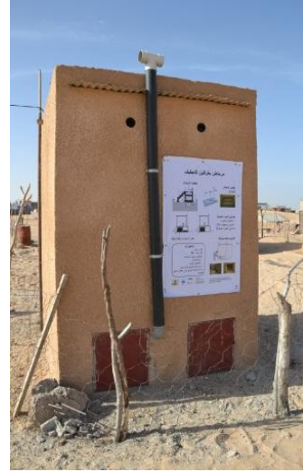
شكل رقم 6 : مثال لمراض ذي حجرات تجفيف بنواكشوط.
