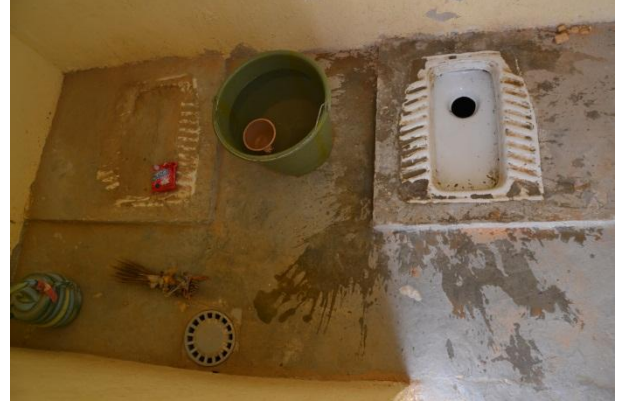
الشكل رقم 15: مرحاض محسن ومُهَوَّى ذو بالوعتين (VIP) بحي الترحيل، توجد على يسار المدخل آبار تصفية مياه الاستحمام والمياه السوداء.
