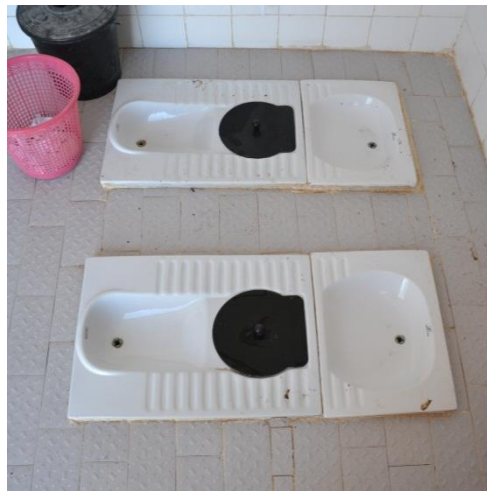
الشكل رقم 13: حوض ذو ثلاث فتحات للفصل مركب في المغرب (واحد لكل تجفيف) فتحة التحويل مغلقة بغطاء من البلاستيك.
