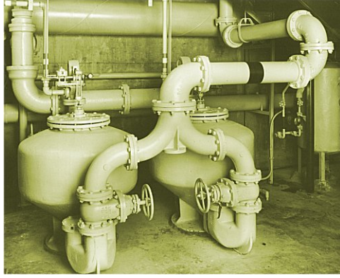
الشكل 5-2: الطارد الهوائي
