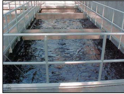
الشكل 3-23: الهاضم الهوائي
