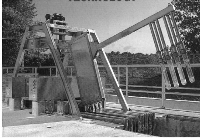
الشكل 3-21: التعقيم بالأشعة فوق البنفسجية
