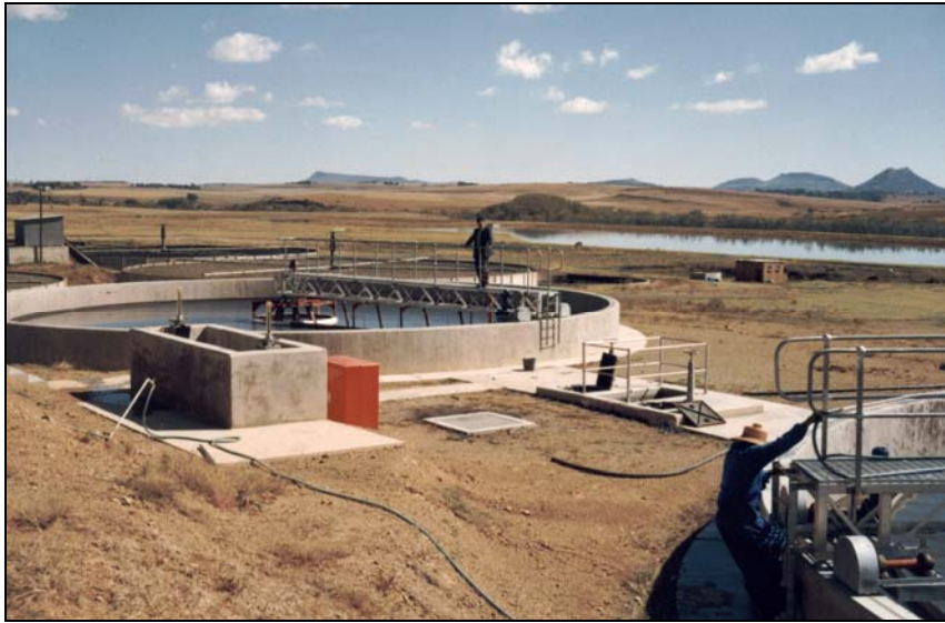
الشكل 3-10: أحواض الترويق (الترسيب) الأولي
