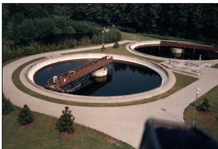
الشكل 3-17: أحواض الترويق (الترسيب) الثانوي أو النهائي
