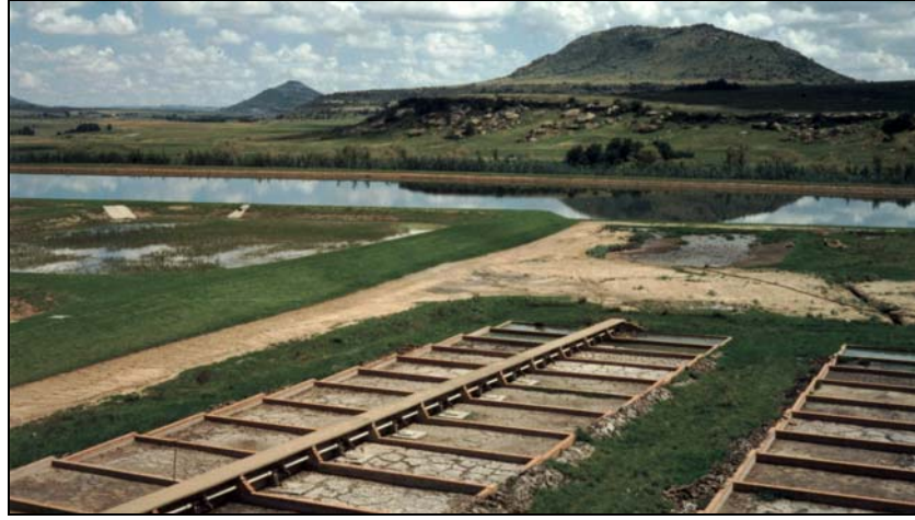
الشكل 3-29: أحواض التجفيف الرملية
