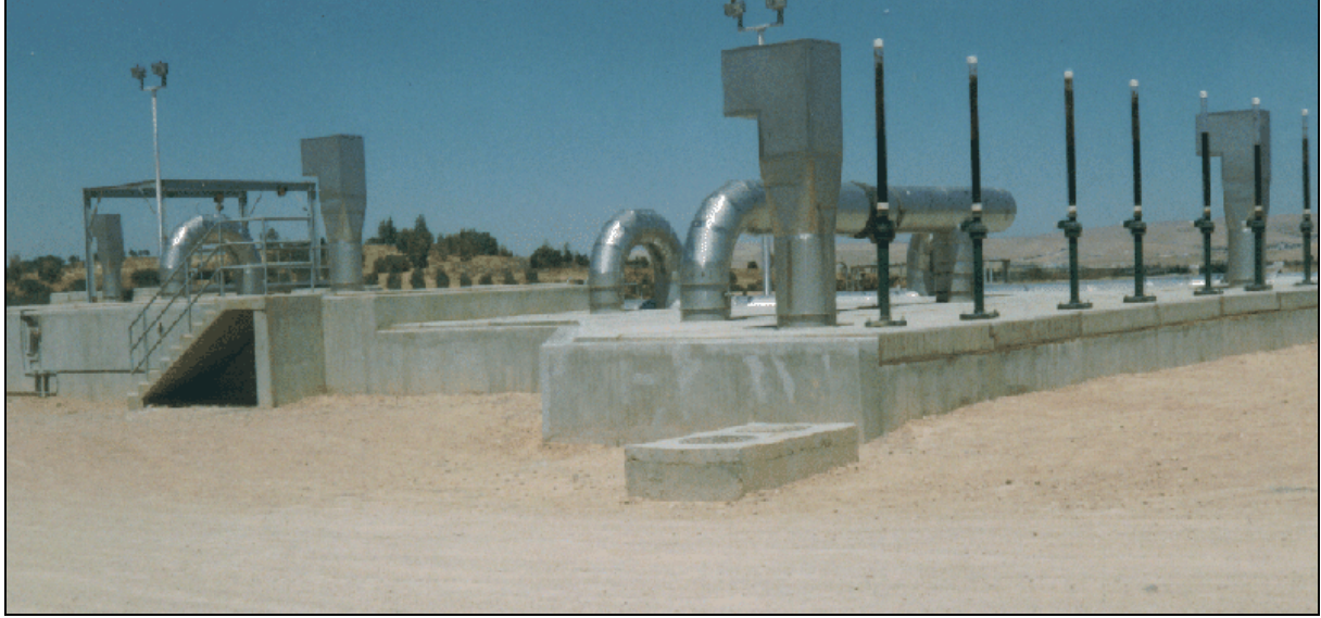
الشكل 3-35: أبراج غسيل الروانح أو المزيلات الرطبة
