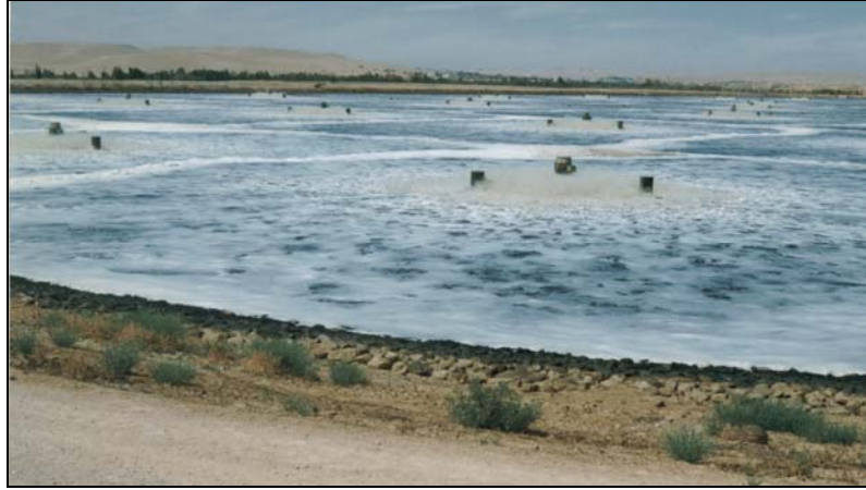
الشكل 3-12: الأحواض (الاهوار) المهوأة
