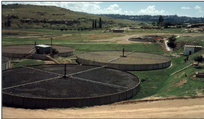
الشكل 3-13: المرشحات الحيوية أو النازة
