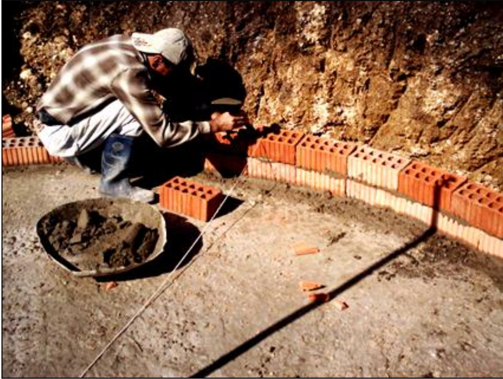
بدء بناء المخمر في محطة زاهد (طرطوس) و محطة السماقيات (درعا)
