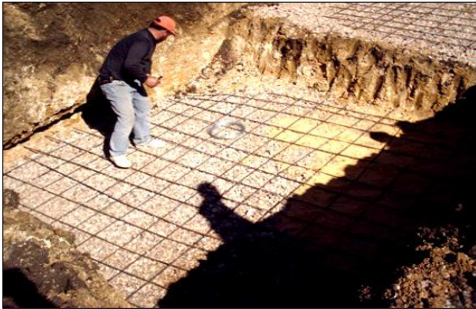
تسليح أرضية الحفر في محطة زاهد (طرطوس) أو محطة السماقيات (درعا)
