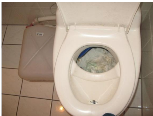
Figura 2: Baño seco con separación de orina
