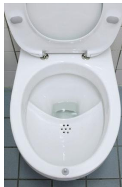
Figura 3: Baño (común) con separación de orina
