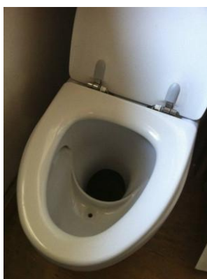
Figura 5: Inodoro seco con separación de orina
