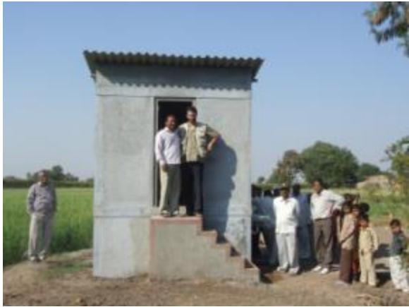
Ready to use UDDT
