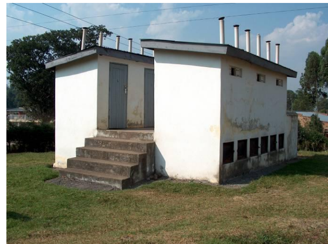
Double vault UDDT in Kabale (Uganda)
