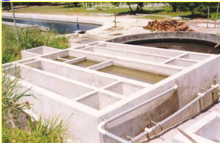
Decanto Digestor com Filtro Anaeróbio (UFRN)
