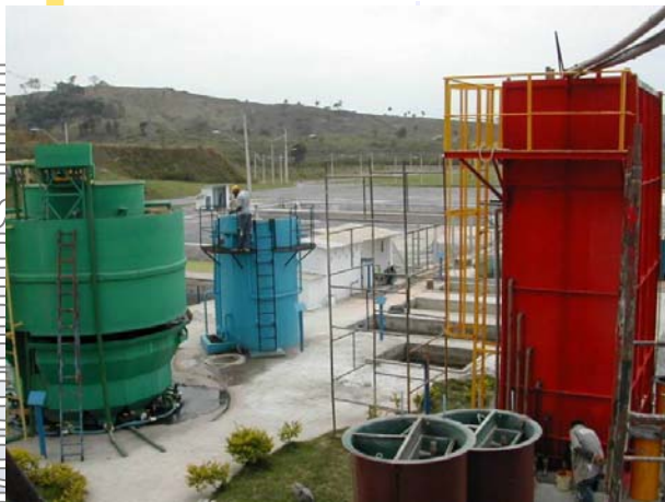
Reatores UASB (UFMG)
