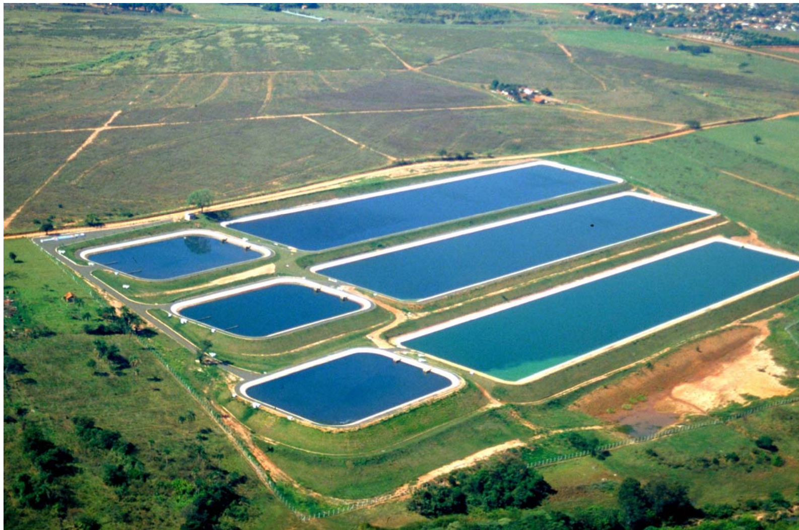
Vista das Lagoas de Estabilização de Lins/SP
