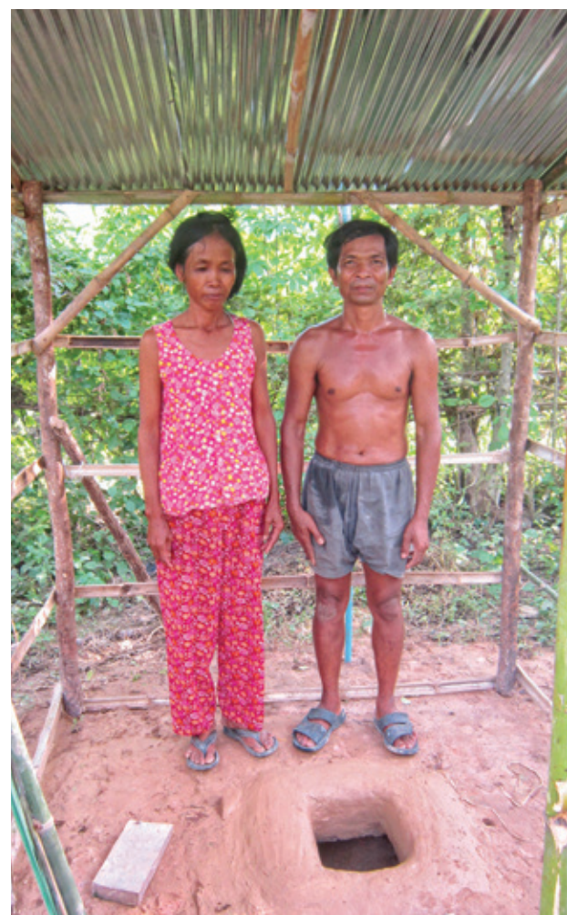
Latrine à fosse sèche pour famille pauvre
