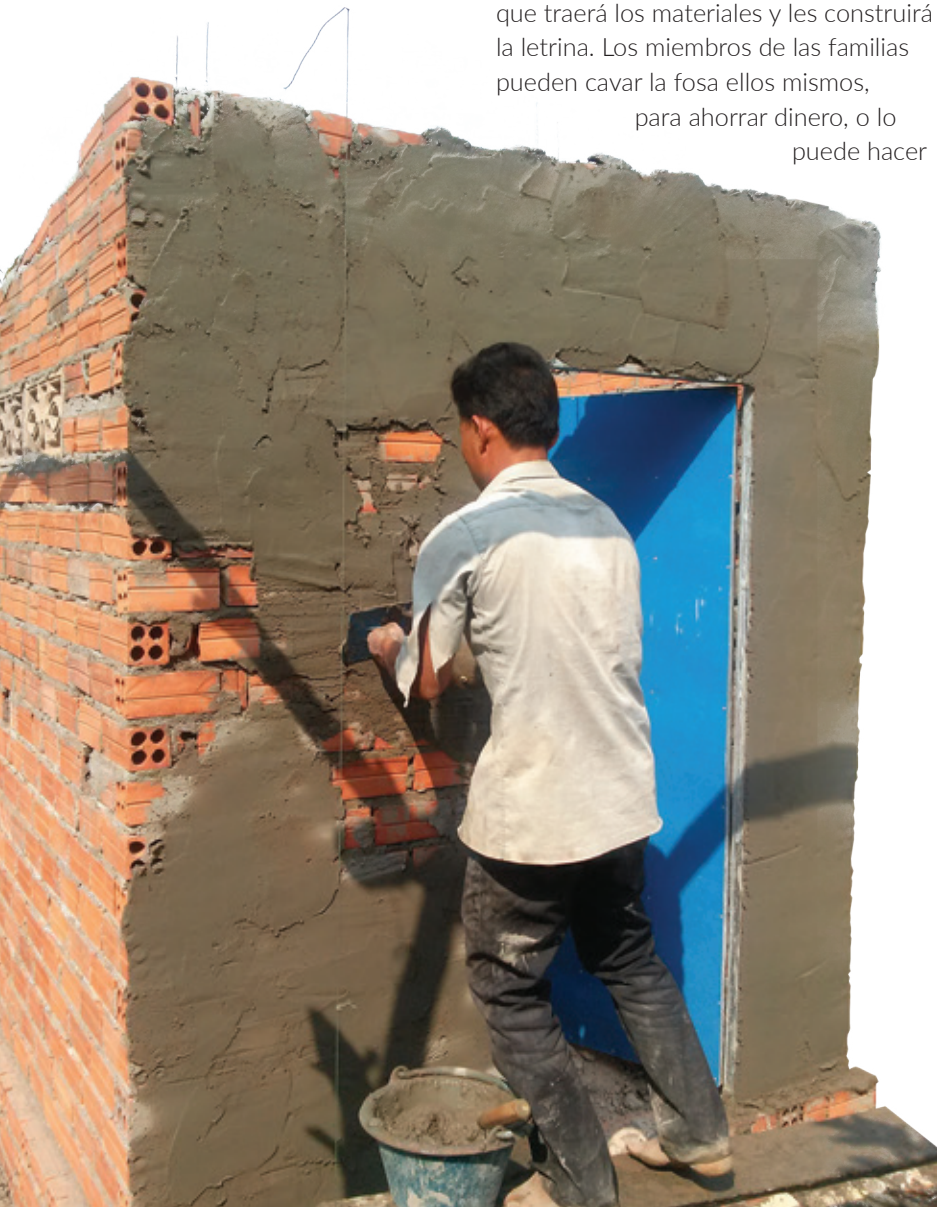
Albañil local trabajando en la construcción de una letrina
