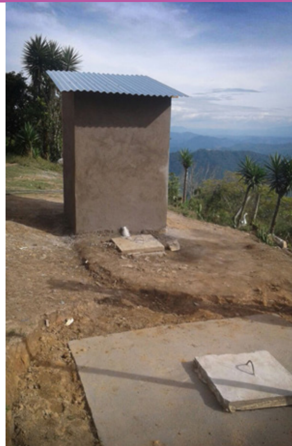
Toilette à chasse manuelle avec boîtier de distribution et une fosse.
