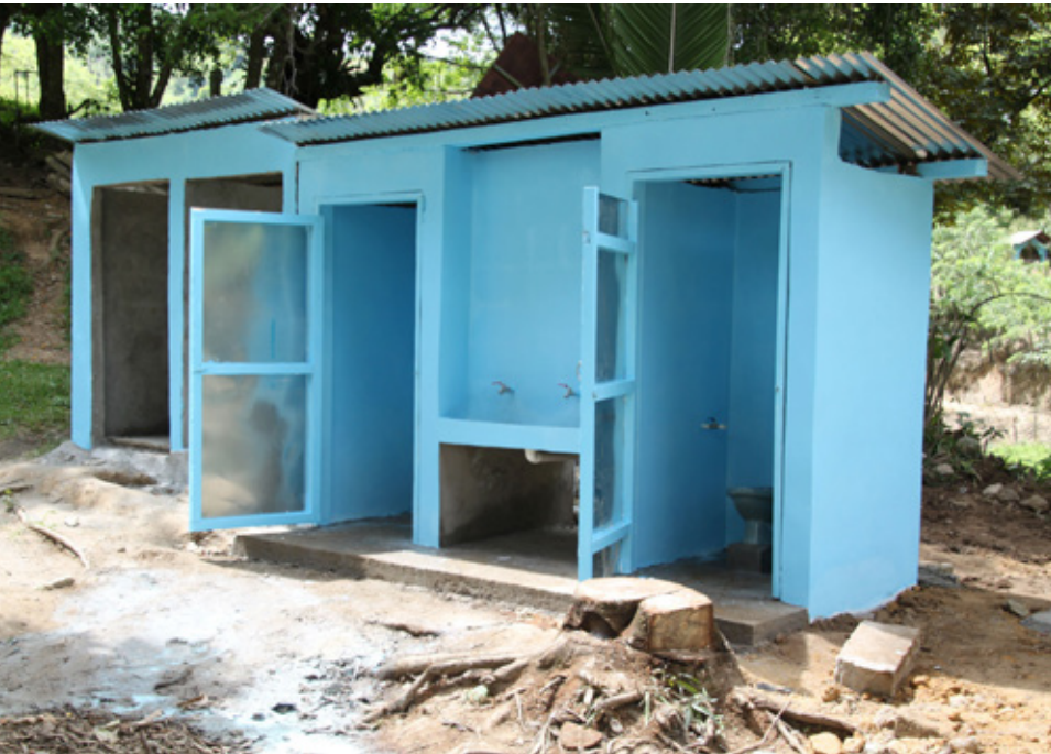
Toilettes avec poste de lavage des mains dans une école.
