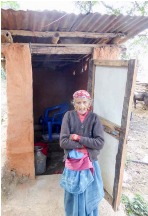
AU NÉPAL, UNE LATRINE ADAPTÉE À UN HOMME DONT LA JAMBE EST CASSÉE. À L'HÔPITAL, ON LUI A SUGGÉRÉ D'UTILISER UNE CHAISE EN PLASTIQUE PERCÉE TANT QUE SA JAMBE EST DANS LE PLÂTRE. SA FEMME (ICI) ENLÈVE LA CHAISE LORSQU'ELLE SE REND AUX TOILETTES ©SUE CAVILL
