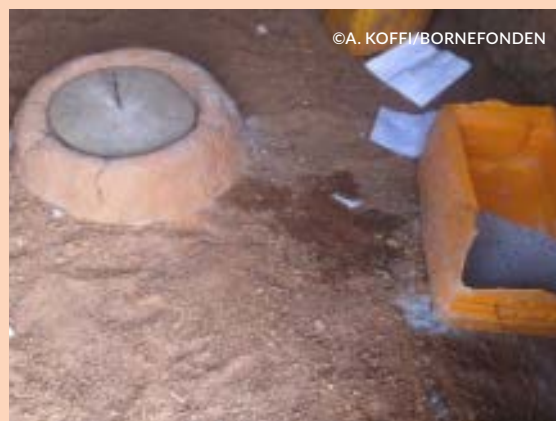
Un orifice légèrement surélevé sur lequel on peut s'asseoir ou s'accroupir, construit pour N'ingmayo, qui est malvoyante. Ceci l'aide à se positionner au-dessus de l'orifice (Togo)
