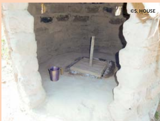
Une dame très âgée et aveugle parvient à s'accroupir, mais a beaucoup de difficultés à utiliser correctement un orifice de taille standard. L'orifice a par conséquent été élargi par son fils, qui a construit les latrines pour elle. (Nigéria)
