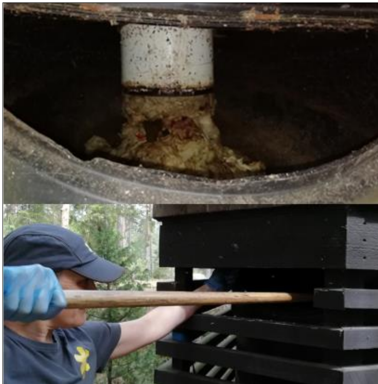
Kuva 24. Årsjön Clivus-käymälä tukkeutui helposti käymäläjätteestä ja edellytti viikottaista huoltoa haralla. Kuva: Lauri Värri.
