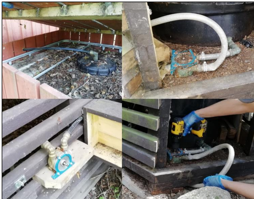
Kuva 22. Tyrestan kansallispuistossa suotonesteen poisto käymäläastiasta tapahtui akkuporakonekäyttöisellä pumpulla. Vasemmalla Stensjödalin suotonestesäiliö sekä suotonestepumppu ja oikealla Årsjön suotonestepumppu sekä malliesimerkki pumpun käytöstä. Kuva: Lauri Värri
