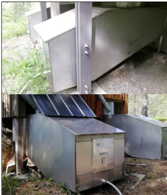
Kuva 28. Mullis 2000 – kuivakäymälöissä on iso pitkänomainen käymäläjättesäiliö, jossa on kalteva pohjaprofiili. Kuvassa Skuleskogenin kansallispuiston pohjoisen sisäänkäynnin (yläkuva) ja Tärnättvattnenin taukopaikan yhteydessä (alakuva) olevat kuivakäymälät. Kuva: Lauri Värri.
