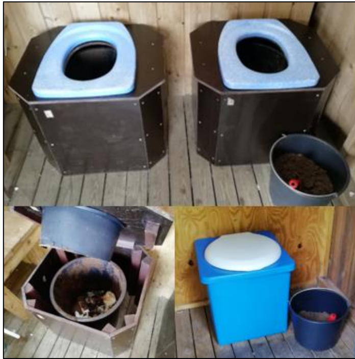
Kuva 34. Tukholman Saaristösäätiön yleisin käymäläratkaisua on saavikäymälä, joka edellyttää tiheää huoltoväliä. Kuvassa saavikäymäläistuimia Björnön luonnonsuojelualueella: vierekkäiset käymäläistuimet (yläkuva) ja saman käymälän istuin avattuna (vas. alhaalla) sekä muovista valmistettu käymäläistuin (oik. alhaalla). Kuva: Lauri Värri.
