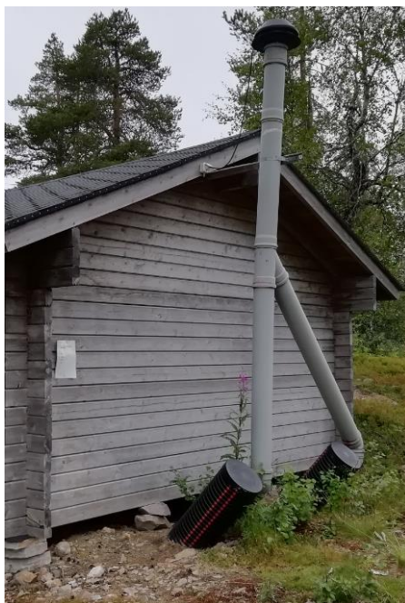
Kuva 60. Koneellisesti tehostetulla ilmanpoistolla pyritään vähentämään imutyhjennyskäymälän sisätilojen hajuhaittoja. Kuvassa Lampivaaran imutyhjennyskäymälä, jossa koneellisesta ilmanpoistosta huolimatta hajuongelma käymälän sisällä oli selkeästi havaittavissa. Kuva: Lauri Värri
