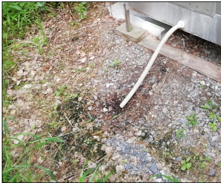
Kuva 30. Skoleskogenin kansallispuistossa käymälöiden suotoneste johdetaan suoraan maahan silloin kun sen kerääminen poiskuljetusta varten ei ole mahdollista. Kuva: Lauri Värri.
