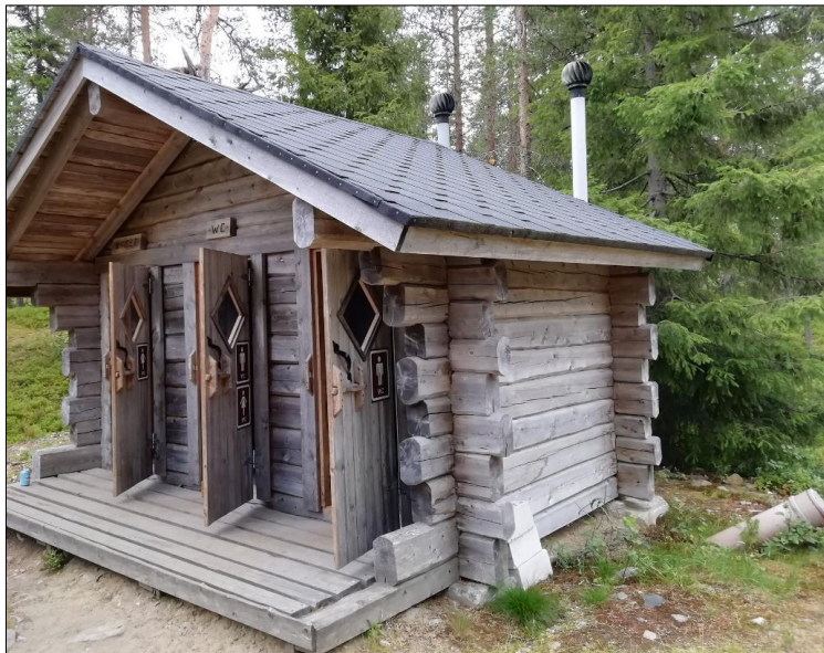
Kuva 59. Maastokohteille, joilla on erityisen suuri kävijämäärä ja huoltotieyhteys, on rakennettu imutyhjennyskäymälät. Kuvassa imutyhjennyskäymälärakennus Karhunjuomalammella. Kuva: Lauri Värri.
