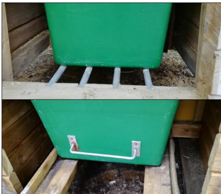
Kuva 62. Kiinteän käymäläjätteen keräävä astia erilaisten tukirakenteiden varassa (metalli, yläkuva ja puu alakuva), jotka pitävät laatikon irti maasta. Kuva: Lauri Värri.
