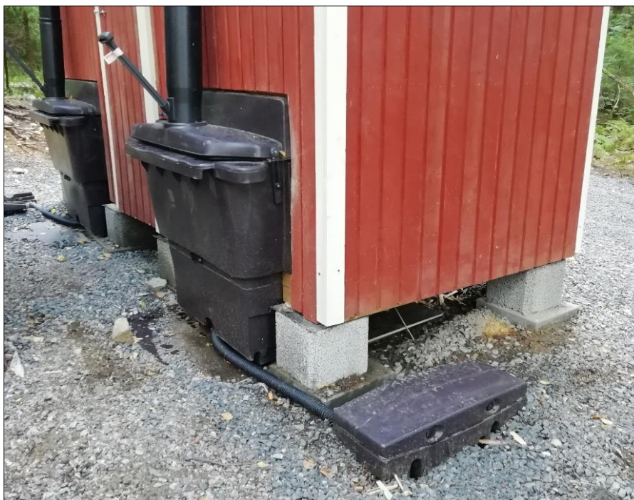
Kuva 50. Sipoonkorven kansallispuistot uusimmat kuivakäymälät Bisajärven taukopaikalla, joilla Suotis-suotonestesuodatimet ovat koe-käytössä. Kuva: Lauri Värri.
