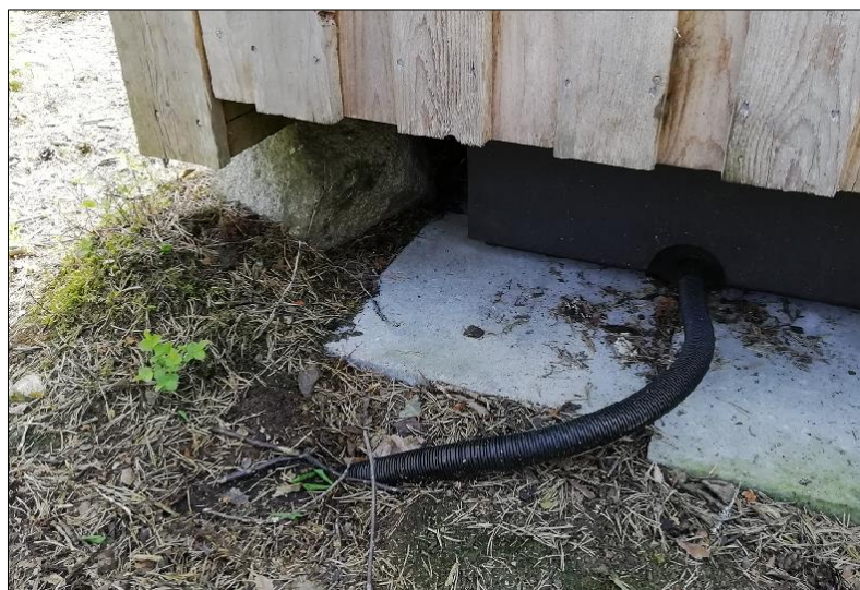
Kuva 56. Vanhemmilla käymäläkohteilla käymälänesteet johdetaan tyypil- lisesti pintamaahan käymälän taakse. Kuvassa nesteputken pää upotettuna maahan Saarisen kuivakäymälällä Rokualla. Kuva: Lauri Värri
