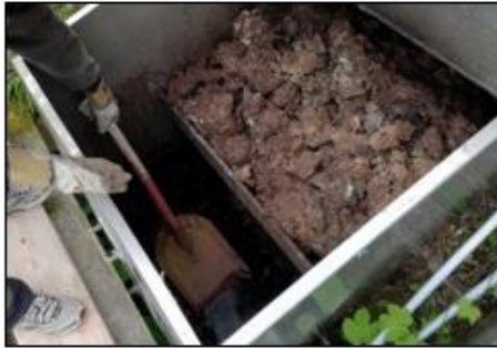
1. Käymälänjätessäiliön takaosa ja kuivahkoa käymälämakkia ennen tyhjennystä. Säiliön pohjalla on suotonestettä.
