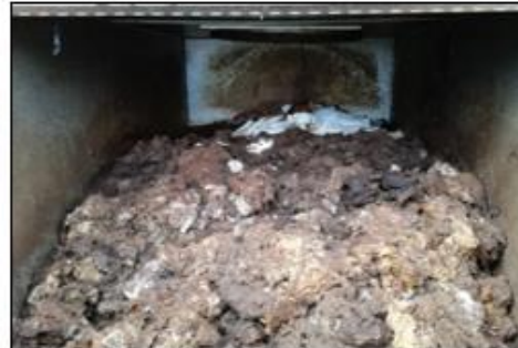
2. Käymälänjätessäiliö sisältäpäin, säiliön etuosassa näkyy käymäläistuimen alla oleva tuorein käymälämakki.
