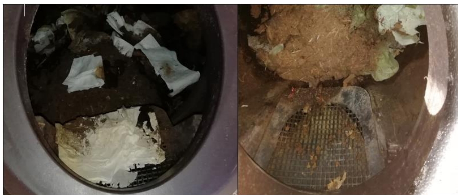
Kuva 58. Rokuan alueella kuivakäymälöiden virtsan erottelu oli usein joko osittain tukossa tai likainen. Kuvassa vessapaperin tukkima (vas.) ja hieman puhtaampi (oik.) virtsanerottelumekanismen ritilä. Kuva: Lauri Värri.
