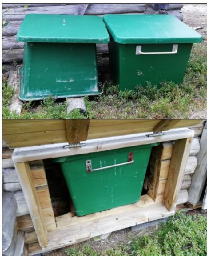
Kuva 61. Pyhä-Luoston kansallispuistossa yleinen käymäläratkaisu oli yksinkertainen lasikuidusta tehty laatikko, joka asetetaan käymälän istuinosan alapuolelle keräämään käymäläjäte. Kuvassa tyhjiä käymäläjätelaatikoita Kapustan päivätuvan yhteydessä (yläkuva) ja laatikko asetettuna käymälään (alakuva).
