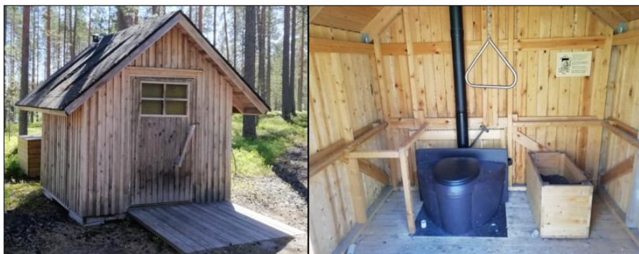
Kuva 53. Rokuanjärven nuotiopaikan yhteydessä sijaitseva käymälärakennus edustaa vanhempaa käymälärakennuskantaa Rokuan kansallispuistossa. Kuva: Lauri Värri.
