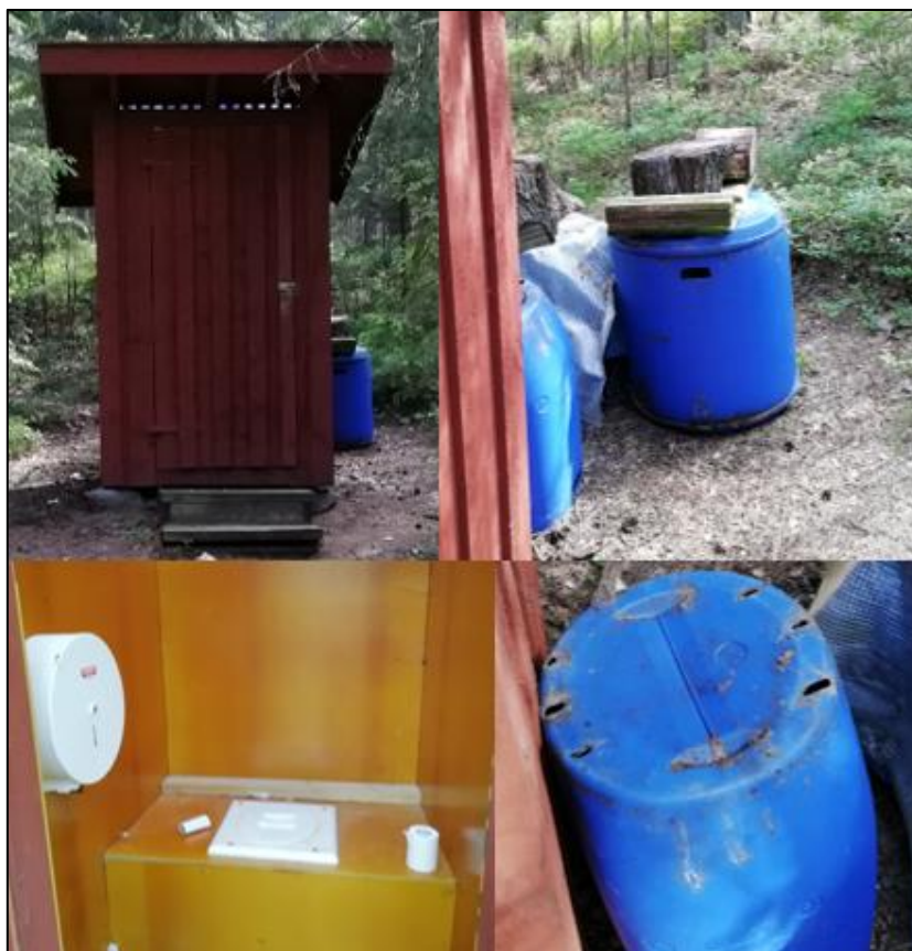
Kuva 29. Skoleskogenin kansallispuistossa on edelleen muutamilla kohteilla käytössä perinteisiä saavikäymälöitä. Kuvassa Tärnättholmarnan autiotuvalla oleva saavikäymälä sekä käymälässä käytettäviä saaveja. Kuva: Lauri Värri.
