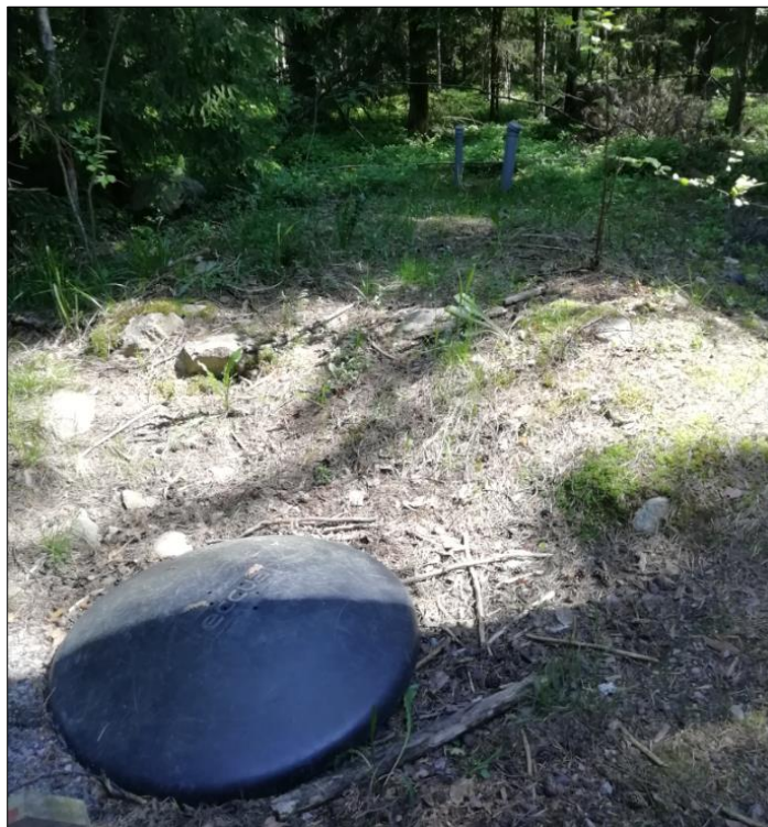
Kuva 46. Sipoonkorven kansallispuiston Flatbergetin parkkipaikan yhteydessä olevan käymälän suotonesteen käsitellään maameytyskentässä. Kuvassa maahan upotettu suotonesteen väliseisotusastia, josta suotonesteet johdetaan maameytyskenttään. Kuva: Lauri Värri.
