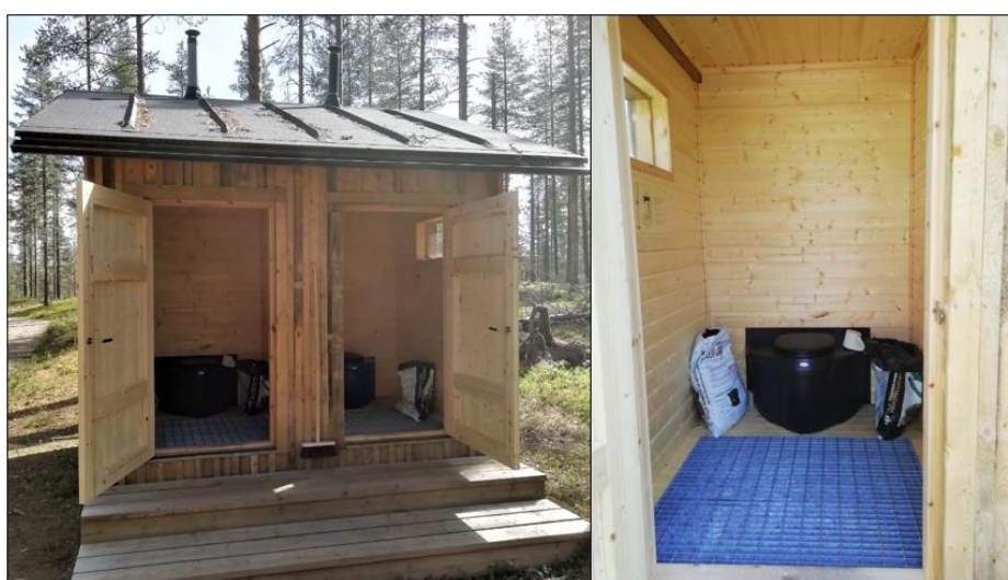
Kuva 54. Uusissa käymälärakennuksissa on paikat kahdelle käymälälle sekä lattian puhtaana pitoa helpottava metalliritilälattia. Kuvassa Rokuan kansallispuistossa sijaitseva Pookivaaran huipun käymälä. Kuva: Lauri Värri.
