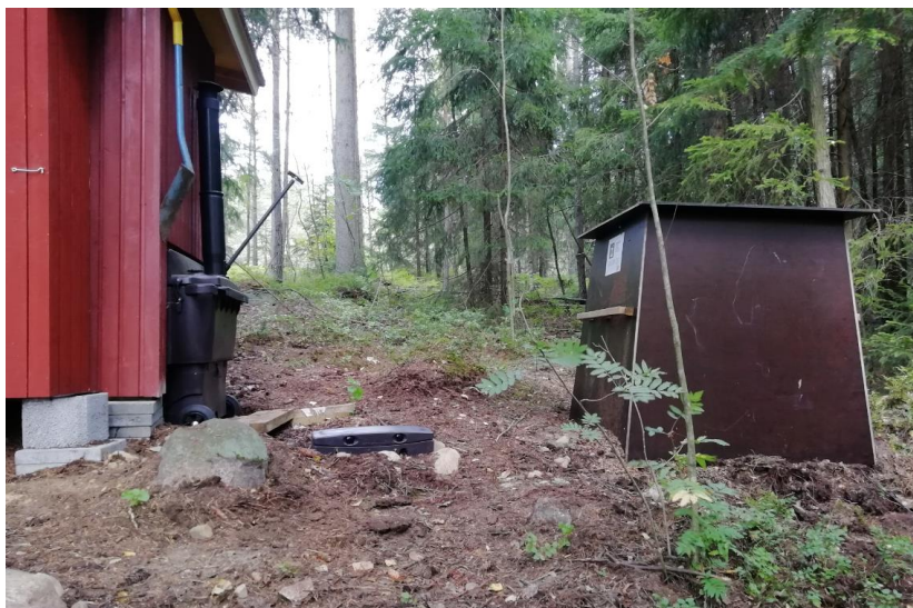
Kuva 48. Oikeaoppiseen käymäläjätteen kompostointiin kuuluu jälkikompostointivaihe. Kuvassa jälkikompostointikehikko Storträskin kuivakäymälän takana Sipoonkorven kansallispuistossa. Kuva: Lauri Värri.
