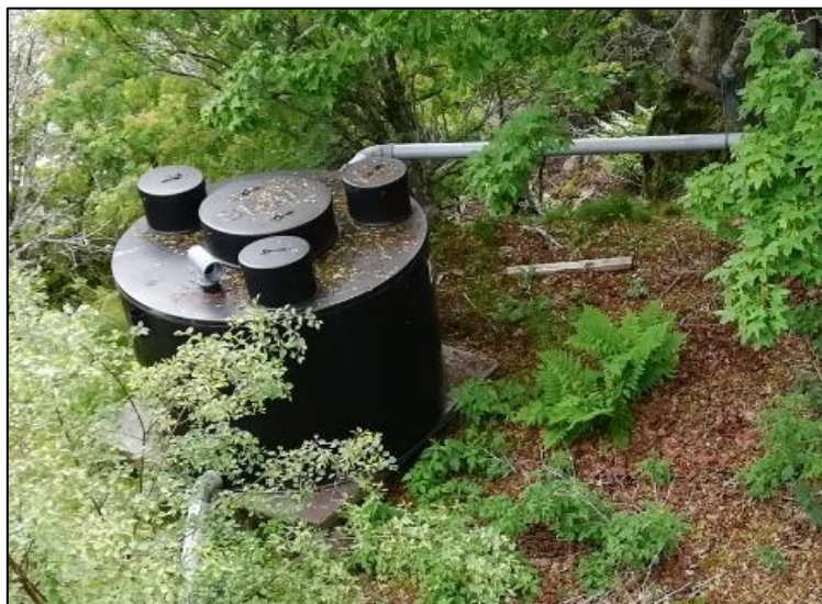
Kuva 32. Högbondenin saarella käymälöistä peräisin oleva nestämäinen jäte käsitellään Ecotechin BDT-biopuhdistamossa. Kuva: Lauri Värri.
