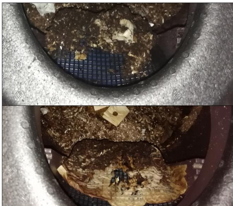
Kuva 51. Virtan erottelumekanismi on herkkä likaantumiselle ja tukkeentumiselle, jos käymälän käyttäjä toimii huolimattomasti kuivikkeeseen ja vessapaperin heittämisessä käymälään. Kuvassa olevat esimerkit ovat Sipoonkorven kansallispuiston Biolan Populett- käymälöistä. Kuva: Lauri Värri.
