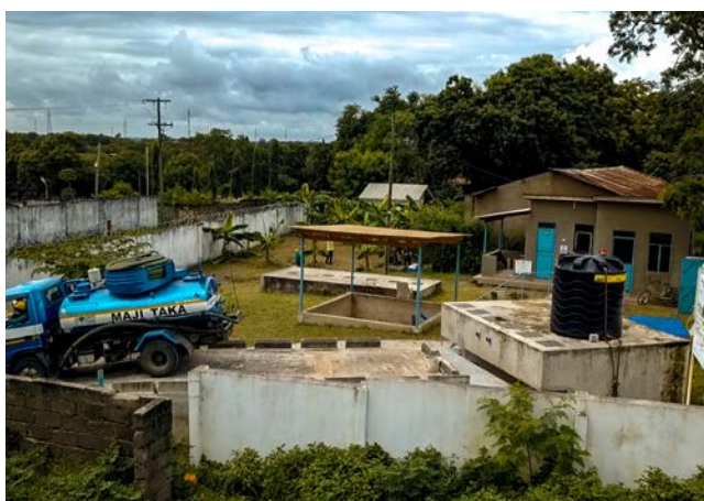
Figure 48 FSTP at Miburani-Temeke
