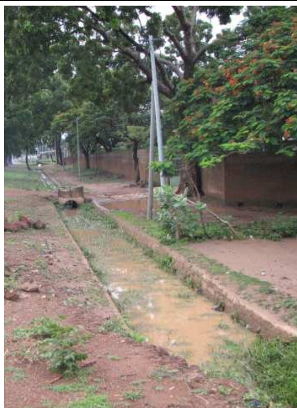
Photo 16 : Le canal d'évacuation des eaux pluviales longeant la RN4 remplis avec de l'eau après la pluie.
