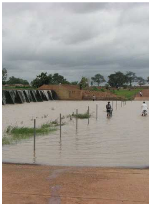
Photo 17 : Le passage du bas-fond à l'Est du barrage N°2 par un radier inondé à la fin de l'époque de pluie.
