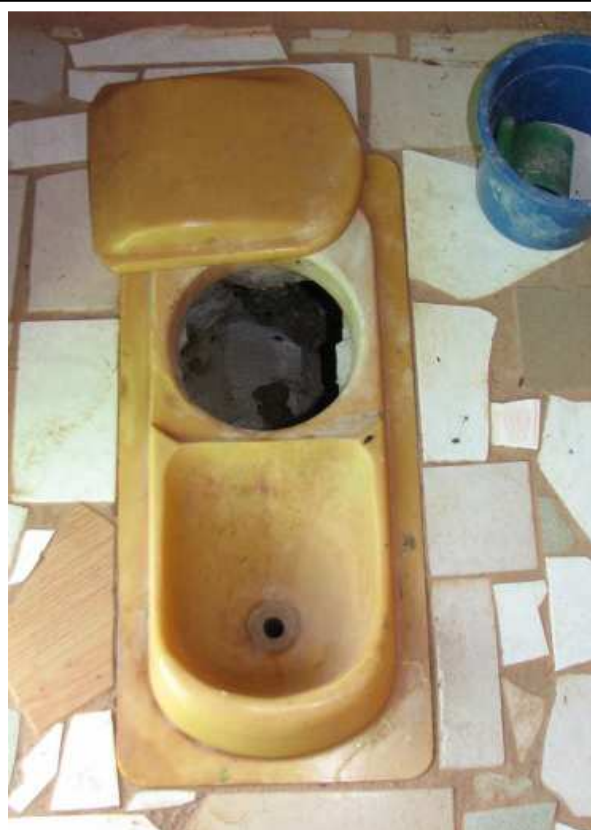
Photo 30 : La Version toilette ECOSAN de position accroupie (modèle chinois).
