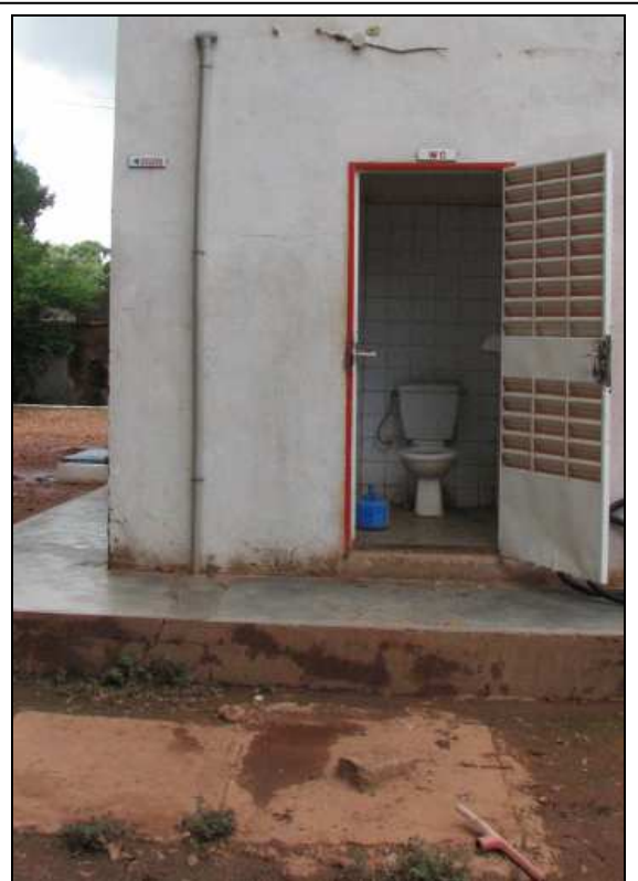
Photo 28 : Toilette à chasse manuelle avec la dalle de la fosse de stockage et le tuyau de ventilation sur la côté de la porte d'entrée (plus fréquemment, les deux installations se trouvent sur la côté arrière de la construction).
