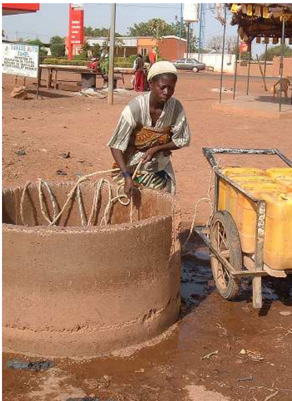
Photo 4 : Puits moderne busé.
