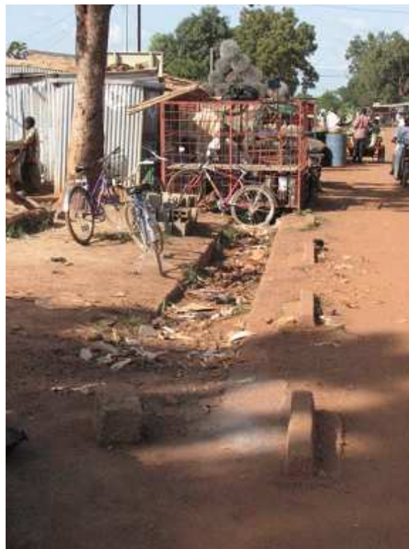
Photo 15 : Canal d'évacuation des eaux pluviales à côté du marché central remplis avec des déchets du marché.
