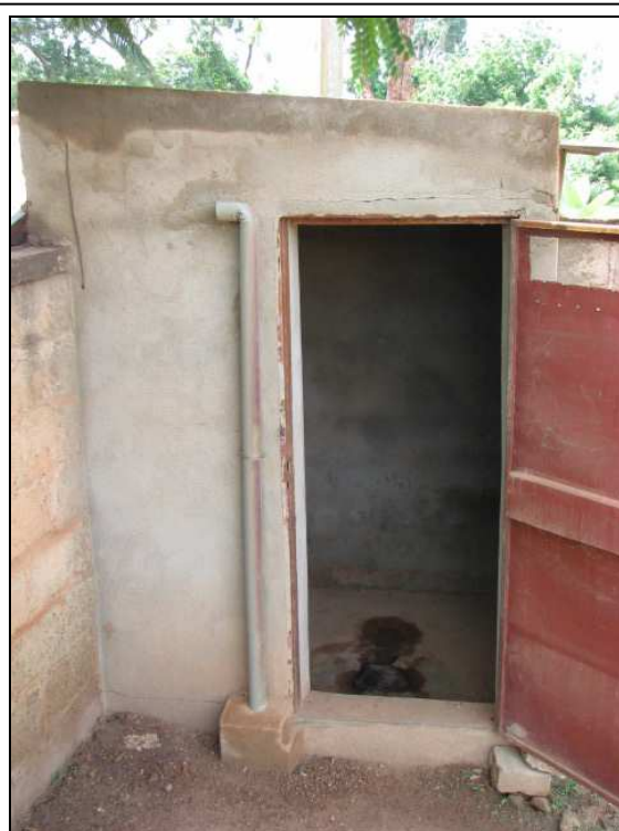
Photo 27 : Latrine VIP avec le tuyau de ventilation sur la côté de la porte d'entrée (plus fréquemment, ce tuyau se trouve sur la côté arrière de la maisonnette) et avec un trou d'accès pour vidanger à la côté arrière de la construction fermé par couvercle à soulever.
