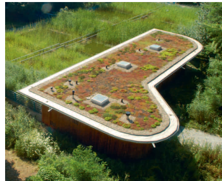
Foto links: Blick auf Bodenfilter zur Regenwasserverdunstung und auf Besucherhaus (mit Gründach), in dem eine mehrstufige Grauwasserrecycling-Anlage untergebracht ist (Nähe Potsdamer Platz, Berlin)
