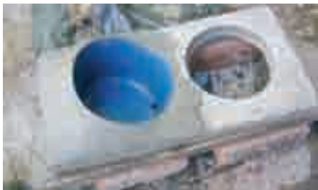
Photo 6-33 : Vue de dessus d'une cuvette à séparation d'urines, position accroupie
