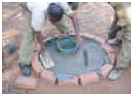
Photo 3-42 : Nivellement du mélange de béton
