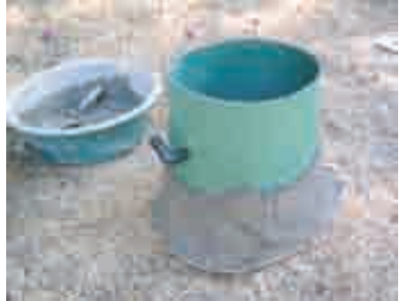
Photo 6-20 : Béton ajouté à mi-hauteur du seau
