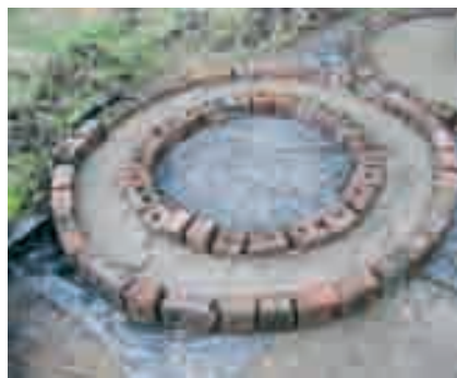
Photo 3-30 : Mélange de béton dans le moule
