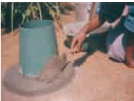
Photo 5-1 : Construction du siège à faible coût.
