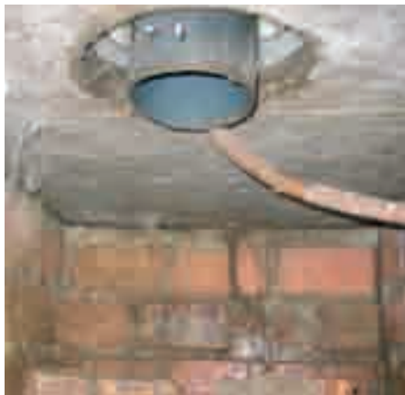
Photo 7-14 : Le tuyau d'urine placé sous la dalle
