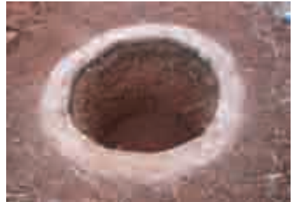
Photo 3-46 : Une fosse creusée à l'intérieur du soubassement.
