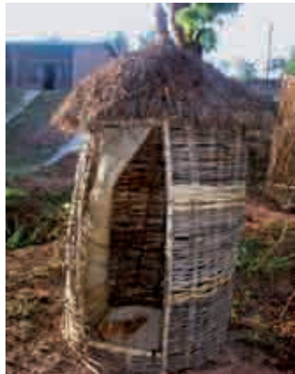
Photo 3-2: Superstructure de latrine construite au-dessus d'une dalle ronde au Malawi.
