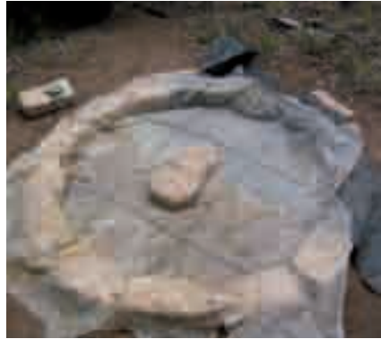
Photo 3-6 : La feuille de plastique étendue dans le moule.
