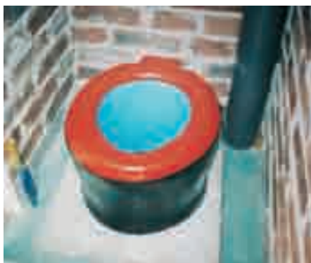
Photo 5-6 : Siège de béton finalisé
