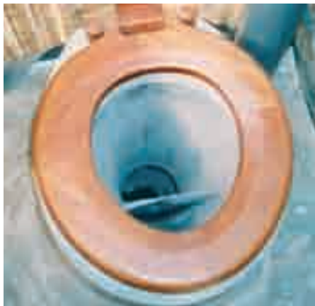
Photo 7-13 : Un siège à séparation d'urines monté au-dessus du sol
