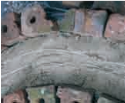
Photo 3-31: Ajout de fils de fer pour renforcement.
