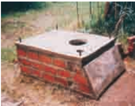
Photo 6-5 : Adaptation de la dalle d'accès de la fosse.
