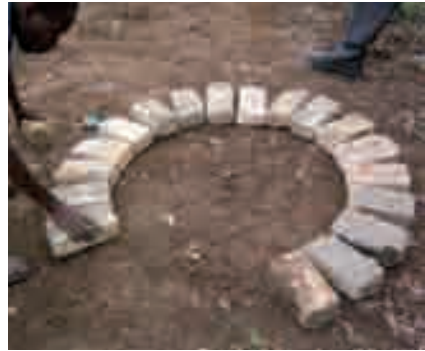
Photo 3-10 : Réalisation du soubassement en briques.
