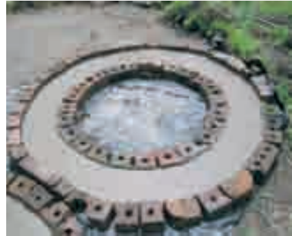
Photo : 3-32: Le reste du mélange de béton versé dans le moule puis nivelé.
