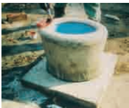
Photo 5-5 : Peinture du siège de béton
