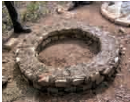
Photo 3-12 : Finalisation du soubassement en briques.
