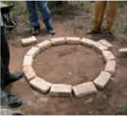
Photo 3-5 : Ceinture de briques pour le moule.
