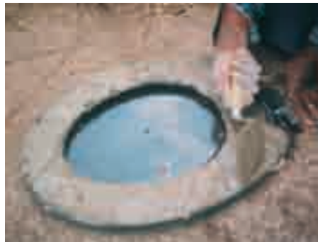
Photo 5-8: Le siège en plastique rempli de béton.
