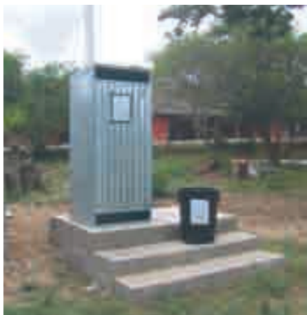
Photo 4-27 : Une Fossa alterna avec une structure métallique
