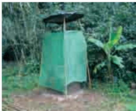
Photo 7-7 : Superstructure autour d'une latrine améliorée.
