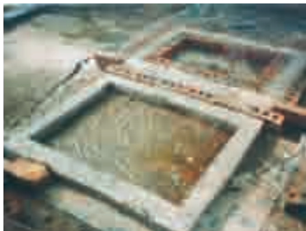
Photo 4-9 : Coffrage de soubassement en briques.
