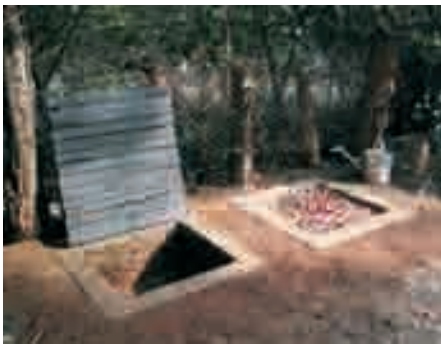
Photo 6-51 : Couverture en bois pour la fosse de compostage fonctionnelle
