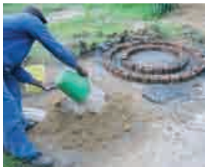
Photo 3-29 : Mélange de ciment et de sable mélange
