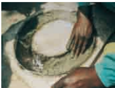
Photo 5-3 : Ajout de béton au moule du siège
