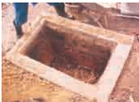
Photo 4-12 : Une Fossa alterna terminée
