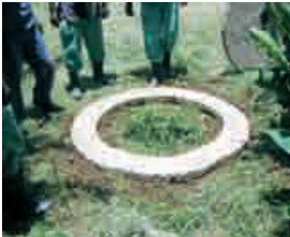
Photo 3-35: Placement du soubassement de béton
