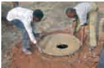
Photo 3-49 : Pose de la dalle sur le soubassement
