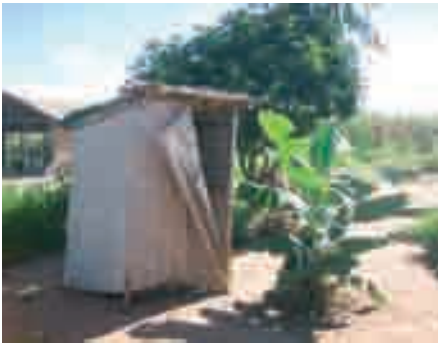
Photo 3-39 : Superstructure en matériaux locaux.
