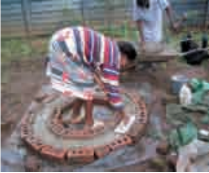
Photo 3-16 : Nivellement du béton.
