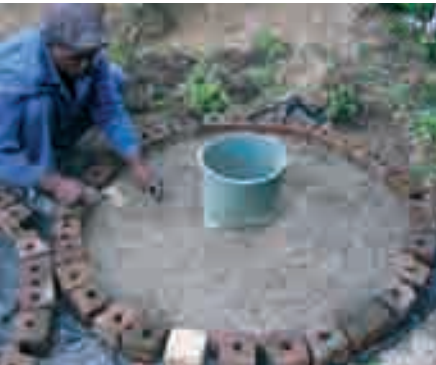
Photo 3-26 : Ajout d'armature pour renforcer.
