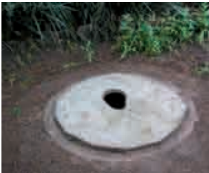
Photo 3-20 : Une dalle de latrine placée sur un soubassement.
