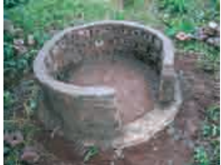
Photo 7-4 : Mur de brique bâti sur le soubassement
