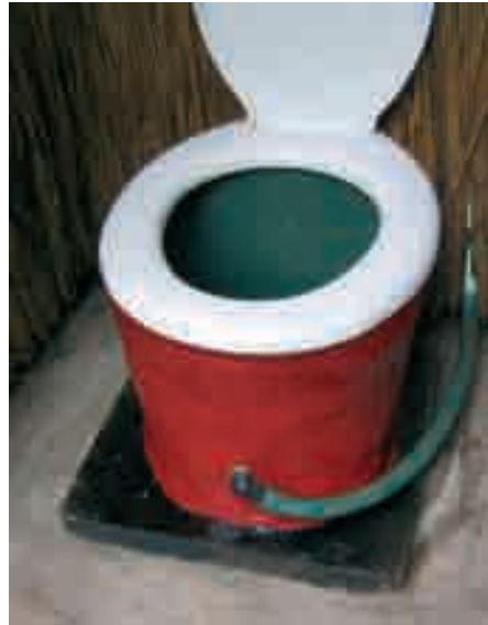
Photo 8-2 : Siège à séparation d'urines
