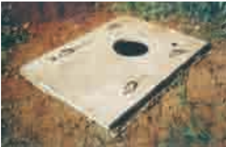
Photo 4-13 : Pose de la dalle de béton
