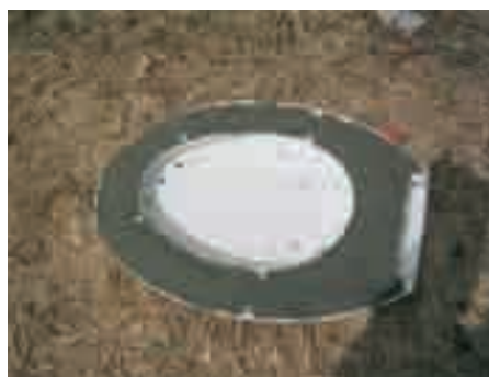
Photo 6-17 : Béton ajouté au siège de latrine
