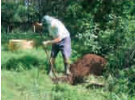
Photo 10-13 : Creusement d'une fosse pour l'arbre
