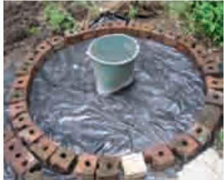
Photo 3-23 : Seau déformé pour faire le trou de défécation.
