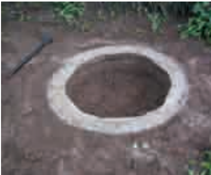
Photo 3-18 : Creusement du trou à l'intérieur du soubassement.
