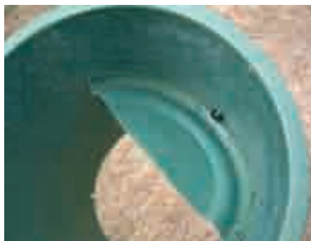
Photo 6-14 : Vue intérieure du coude fixé
