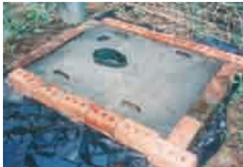
Photo 4-7 : La dalle finalisée à l'intérieur du moule.
