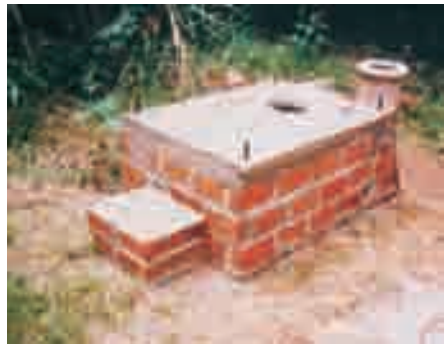
Photo 6-6 : Vue de face de la fosse avec la dalle placée au-dessus.
