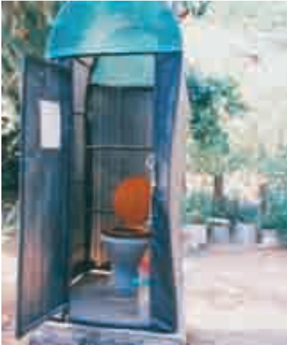
Photo 6-41 : Superstructure faite de tuyaux de polyéthylène recouverts de plastique
