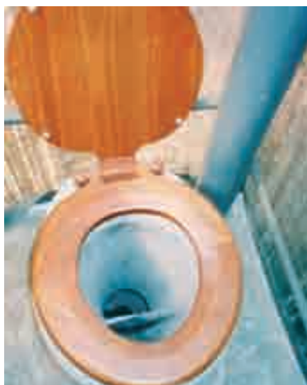
Photo 6-36 : Vue de dessus du siège à séparation d'urines
