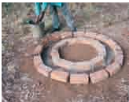
Photo 3-43 : Utilisation de briques pour faire le soubassement.
