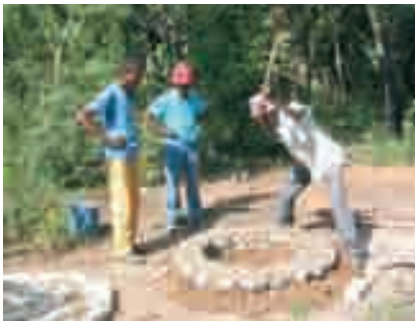
Photo 3-33 : Creusement de la fosse à l'intérieur du soubassement de briques.
