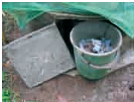
Photo 7-6 : La porte d'accès à la fosse en béton
