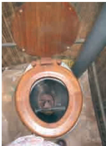
Photo 6-57 : Latrine à séparation d'urines nettoyée
